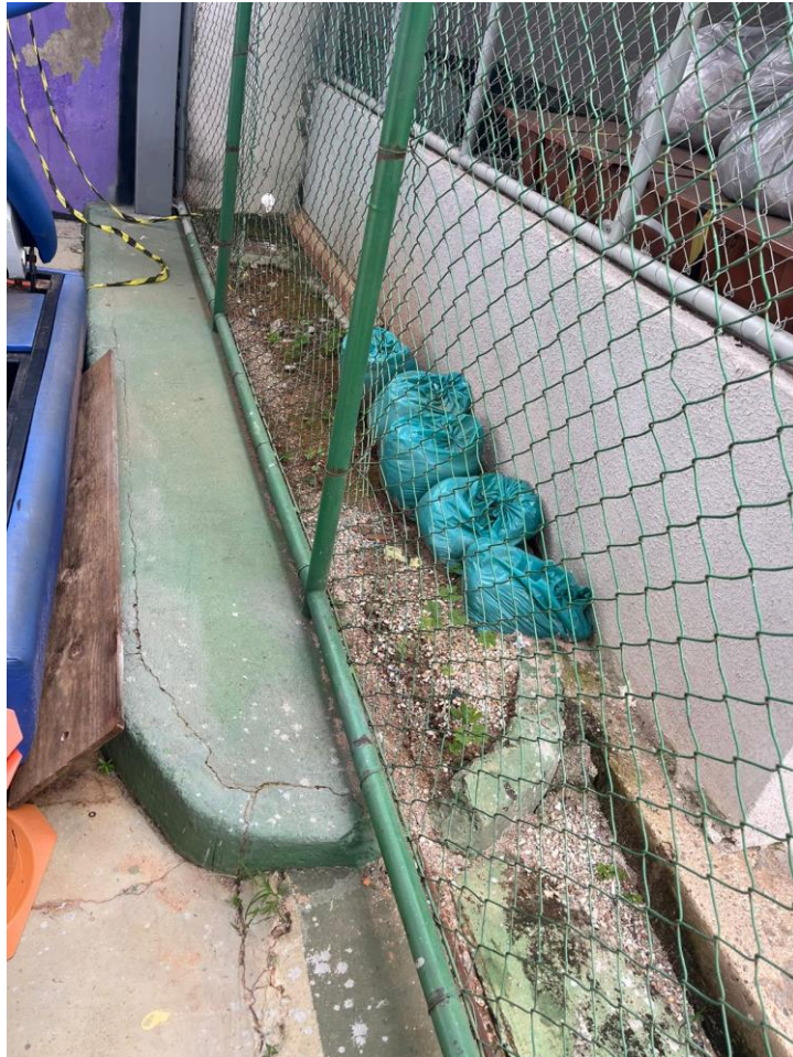
Figura 1 – área para instalação do armário de concreto
